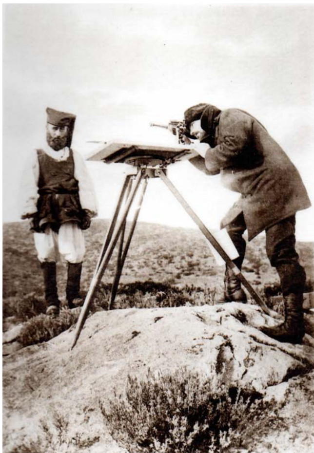
Fig. 1. Rilievi con la tavoletta pretoriana in Sardegna. (Fonte: Mori, 1922).
